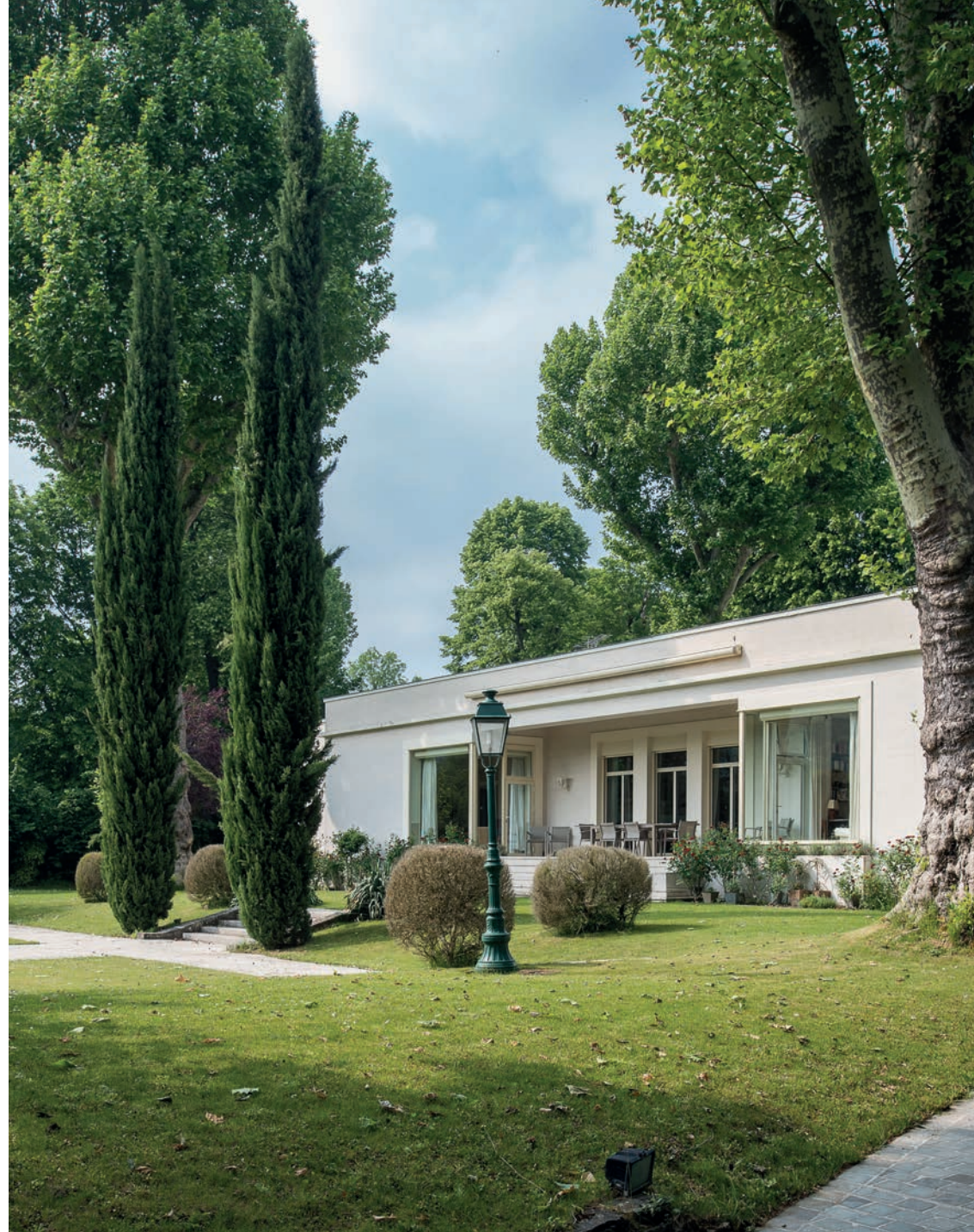
Vendu | En bordure de Seine | Villa Emile Augier | Jardin de plus de 4000 m 2
